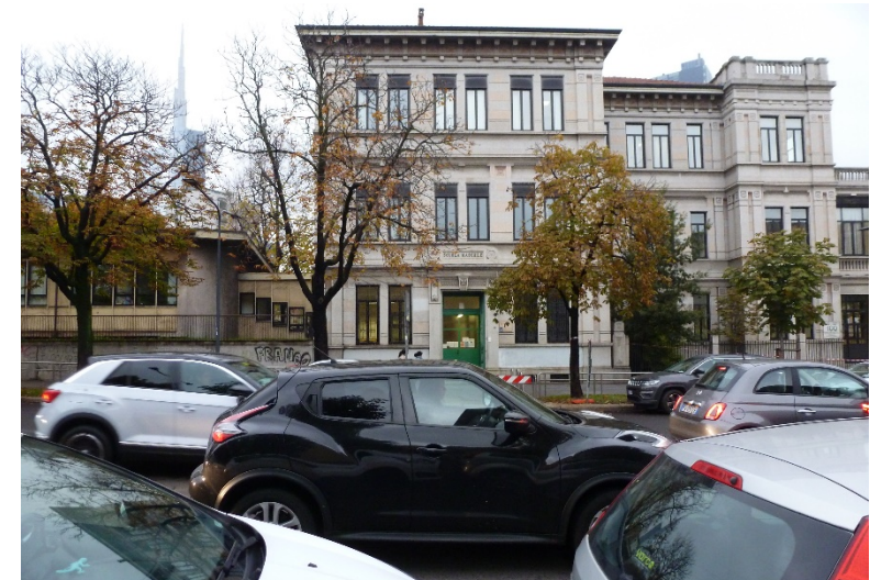
Primaria Giussano, via Bastioni di P. Nuova, MI
